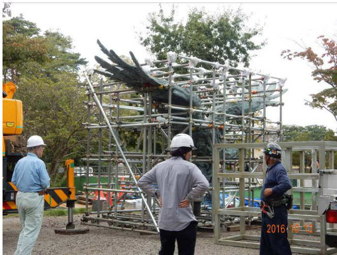
大震災で落下した昭忠碑の金鶏像が修理を終え碑の脇に設置
