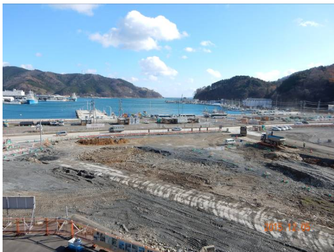
女川港：津波瓦礫は除かれ、嵩上げ工事が進行
