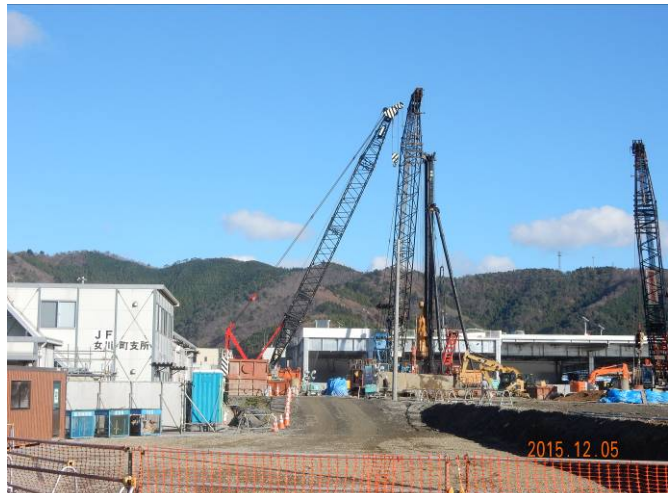
女川漁港復興工事の様子：寄付のコンテナが見える
