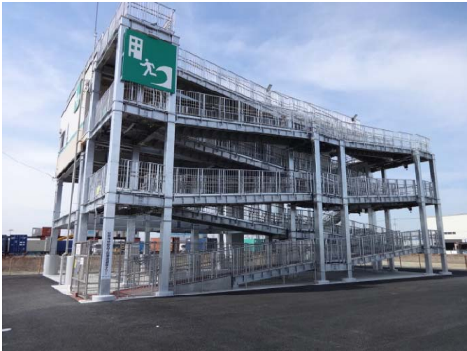
蒲生地区「避難センター」鉄骨造り、高さ10m、収容数200名。
