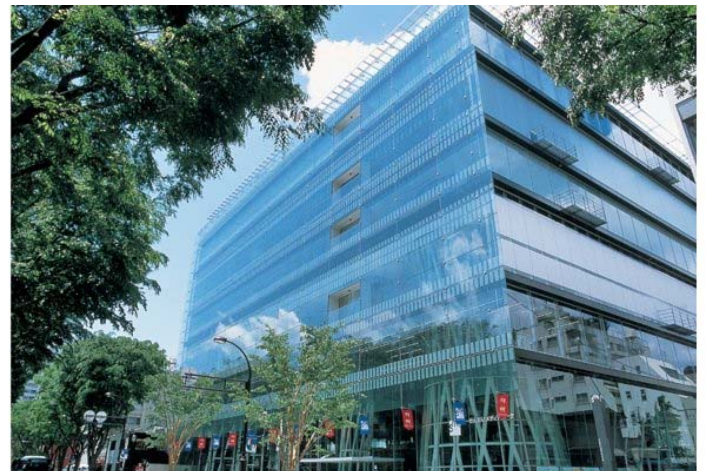
大震災にもビクともせず、特異な設計・施工技術で作られたメディアテークは定禅寺通りの名所。
